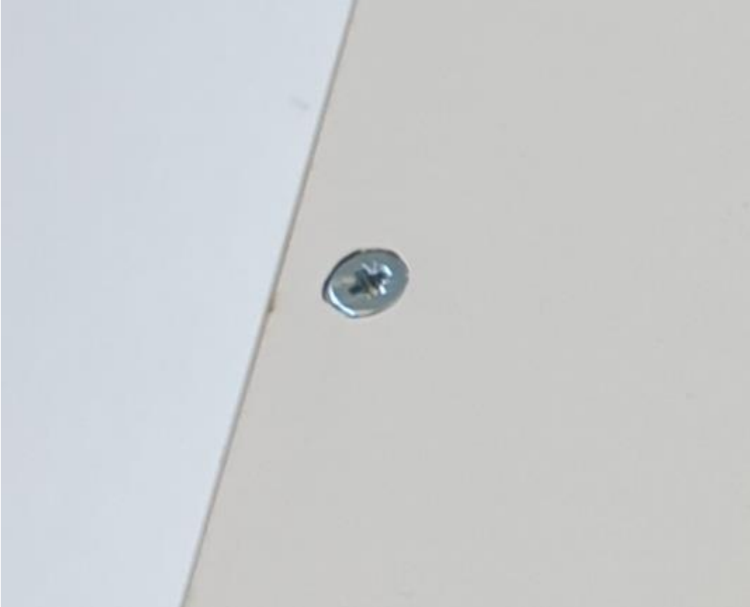
Görselde içeriye gömülmüş şekilde vidalanmış kabin vidası.
